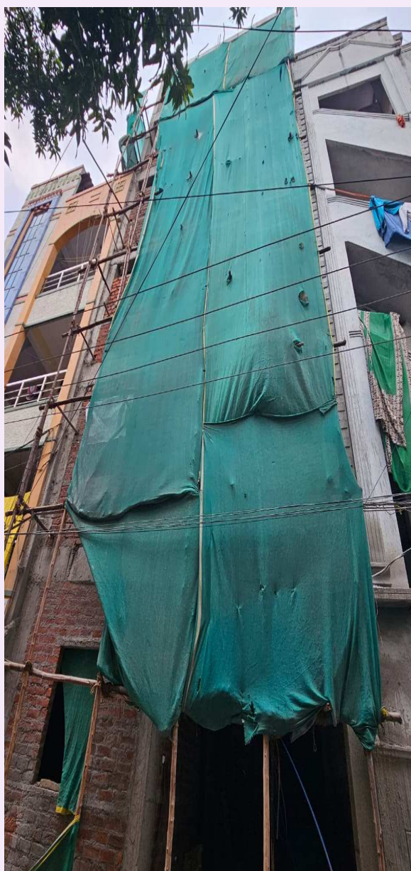
66 గజాల్లో నిర్మాణం అవుతున్న బహుళ అంతస్తుల భవనం 862 EWS.
